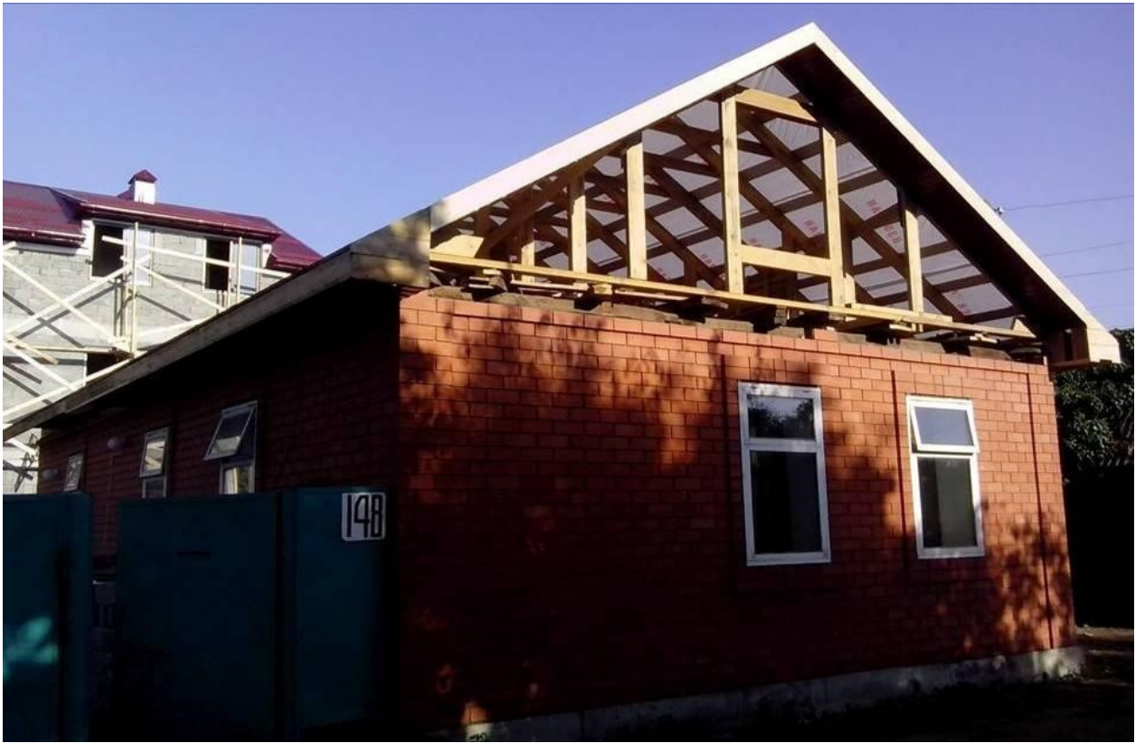
Ağustos 2014' te inşaat devam ederken, bir taraftan bahçedeki müstakil evin çatısı da yenilendi. Kanalizasyon bağlantıları yapıldı.
